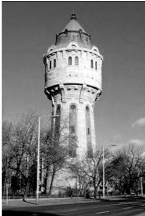
A VÍZTORONY (ÉPÜLT: 1911–1912)
